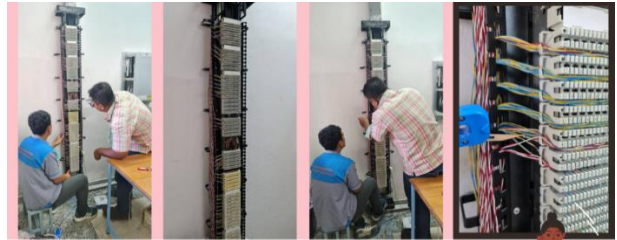
ซ่อมบำรุงสายโทรศัพท์อาคารเครื่องมือฯ 5
